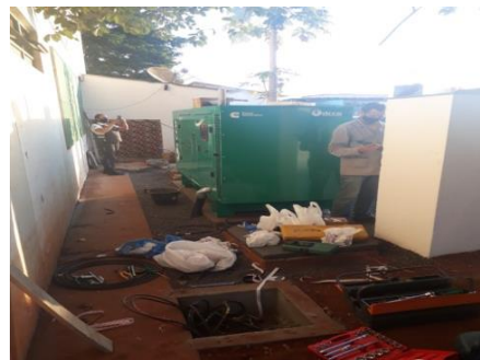
Manutenção preventiva dos ares condicionados
