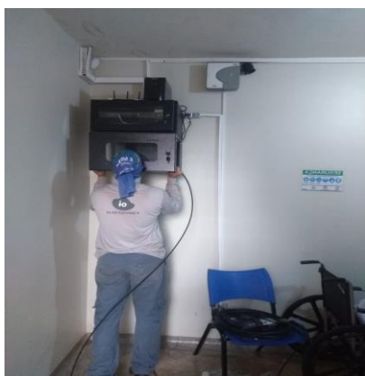
Instalação dos cabos de fibra óptica.
