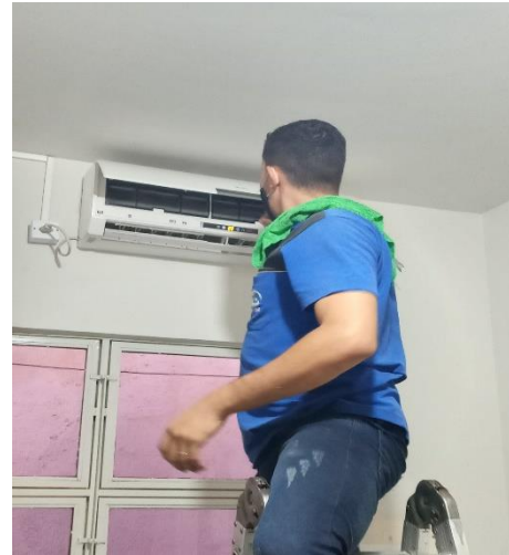
Limpeza do ar condicionado
