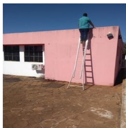
Reparo na encanação da Caixa d'água
